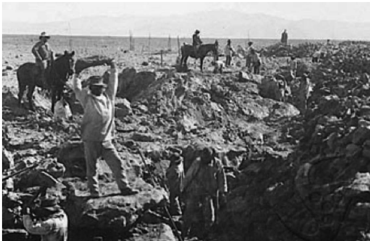
Figura 64: Trabajo de extracción de salitre. Figure 64: Saltpeter extraction.
